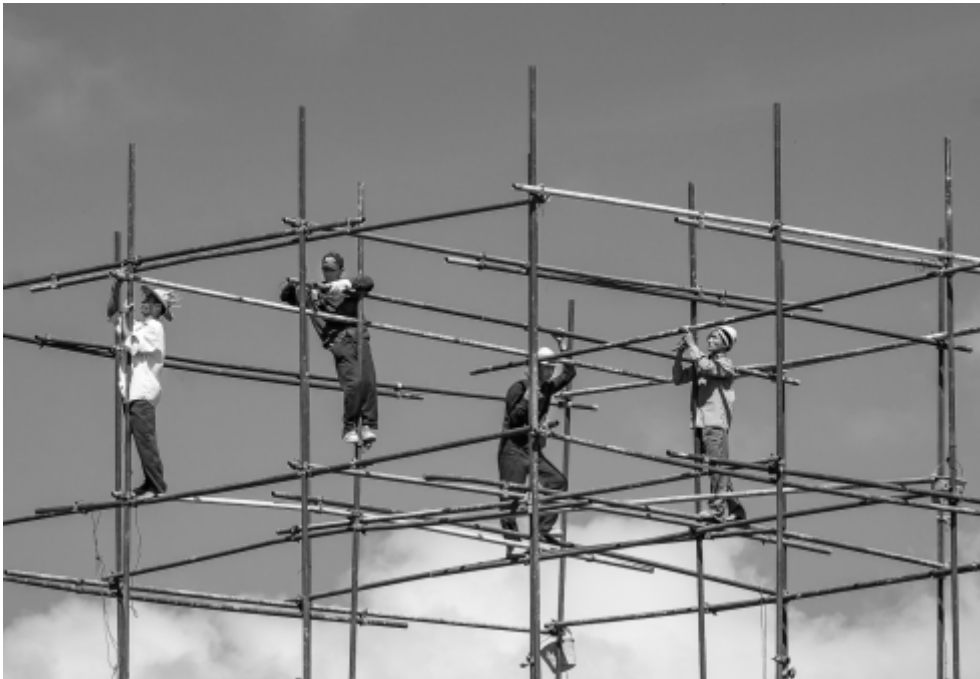
DIPA HM Claudio Pettazzi, Italy, Scaffold
